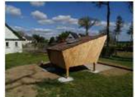
Cabane Vélo à Saint-Bélec, sur l'axe Nantes-Brest (Département d'Ille-et-Vilaine)
